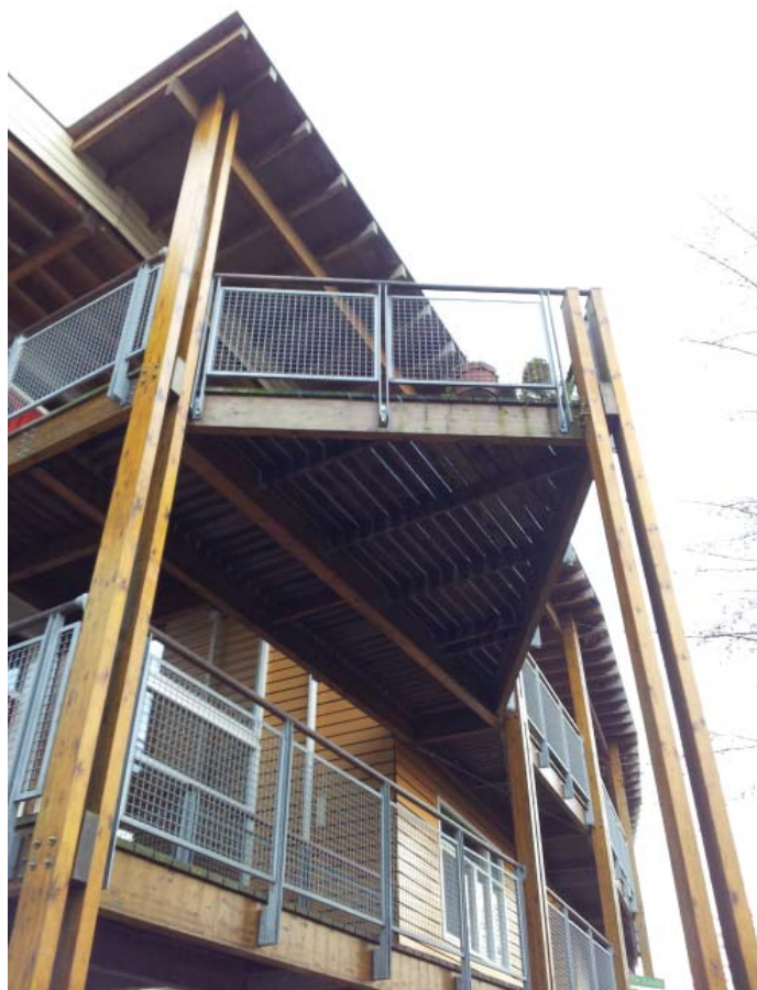
9.3 | Gevel boven de entree van 'Het Kwarteel' | bron: auteur, 2012
